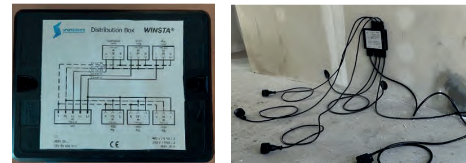
Voorbeeld keukenverdeler met aangesloten kabels
